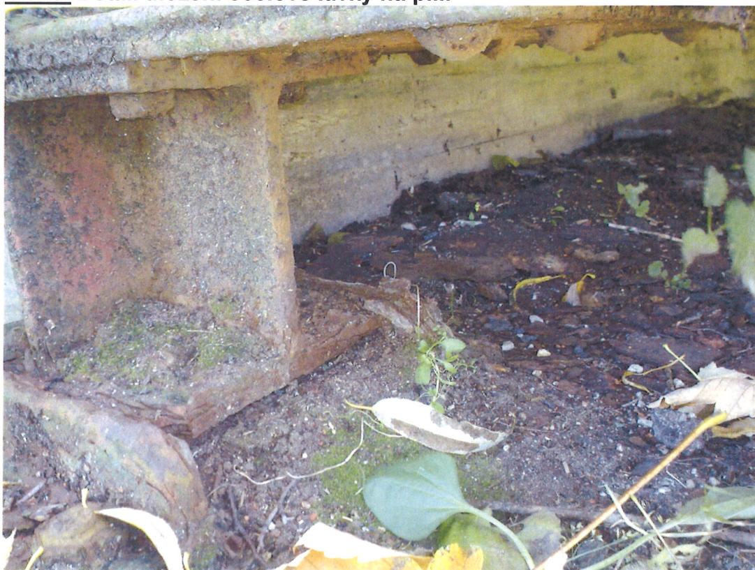
Obr.8: Detail uložení ocelové lávky na pilíř
