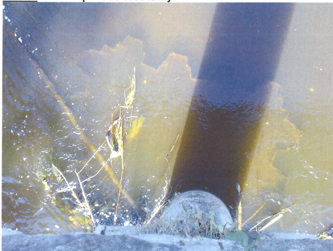
Obr.16: Založení pilířů žb části lávky
