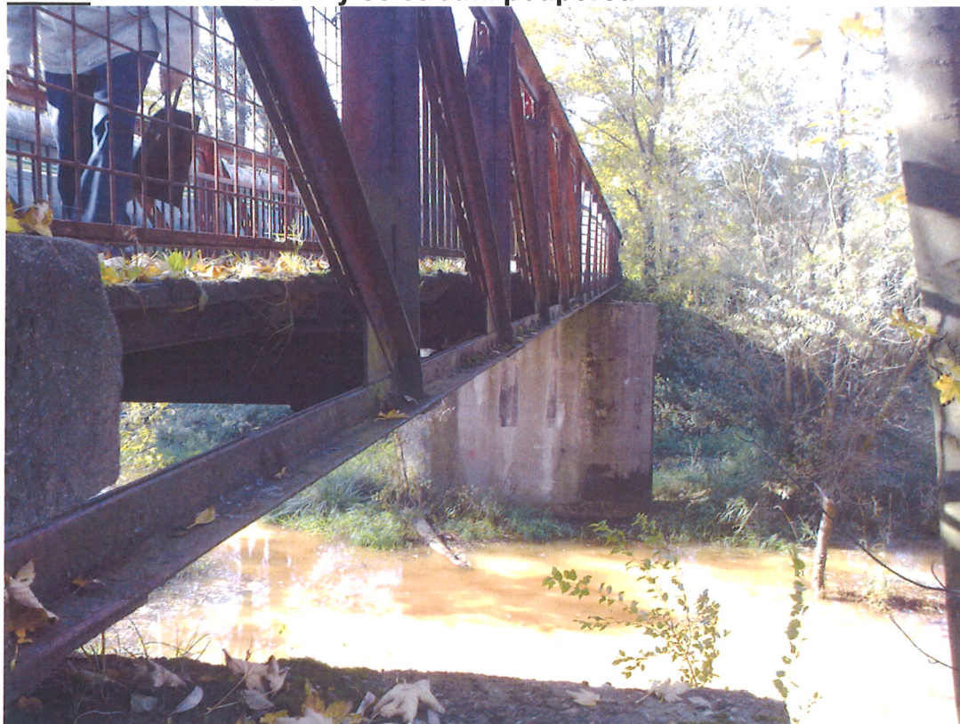
Obr.9: Ocelová část lávky se střední podporou
