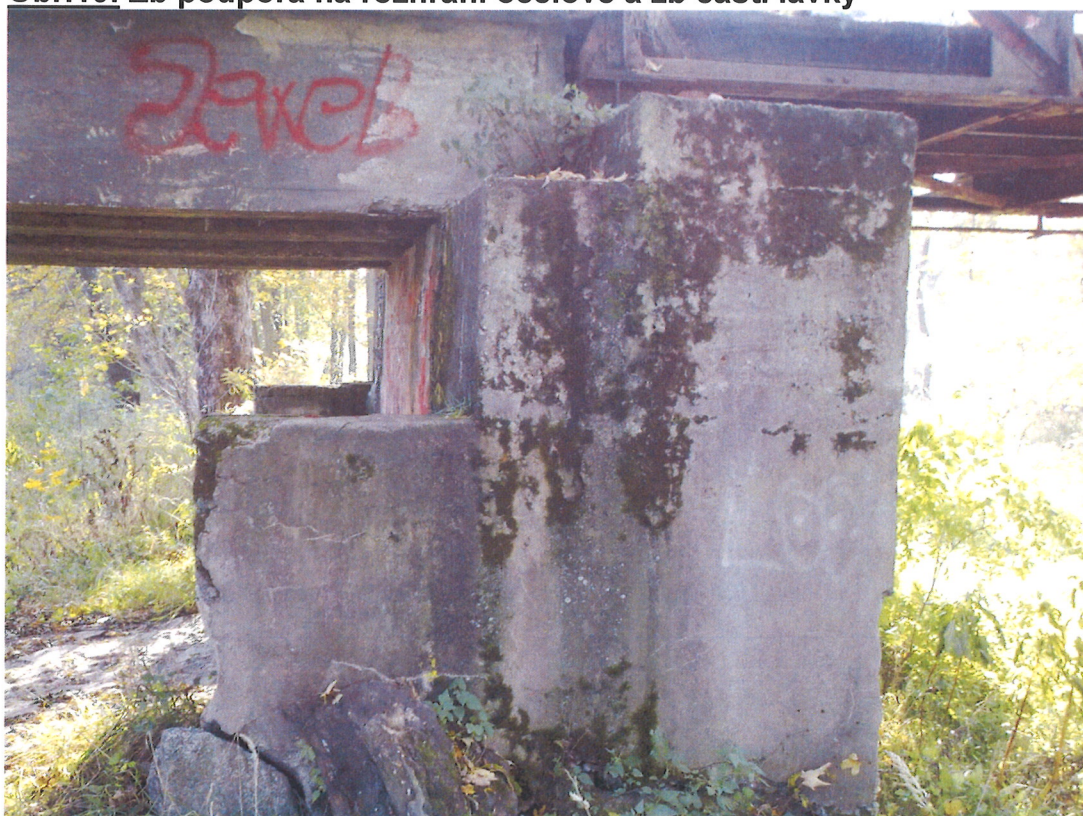
Obr.10: Žb podpora na rozhraní ocelové a žb části lávky
