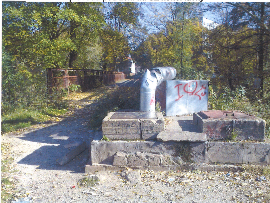
Obr.4: Přejchod teplovodu pod zem na SZ konci lávky
