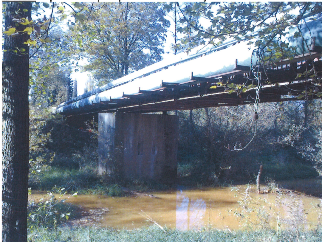
Obr.12: Žb podpora na rozhraní ocelové a žb části lávky
