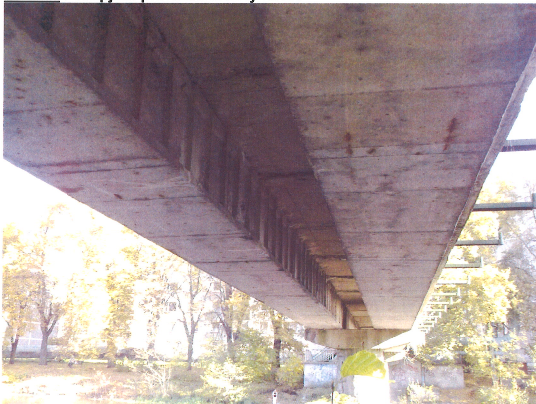
Obr.16: Založení pilířů žb části lávky
