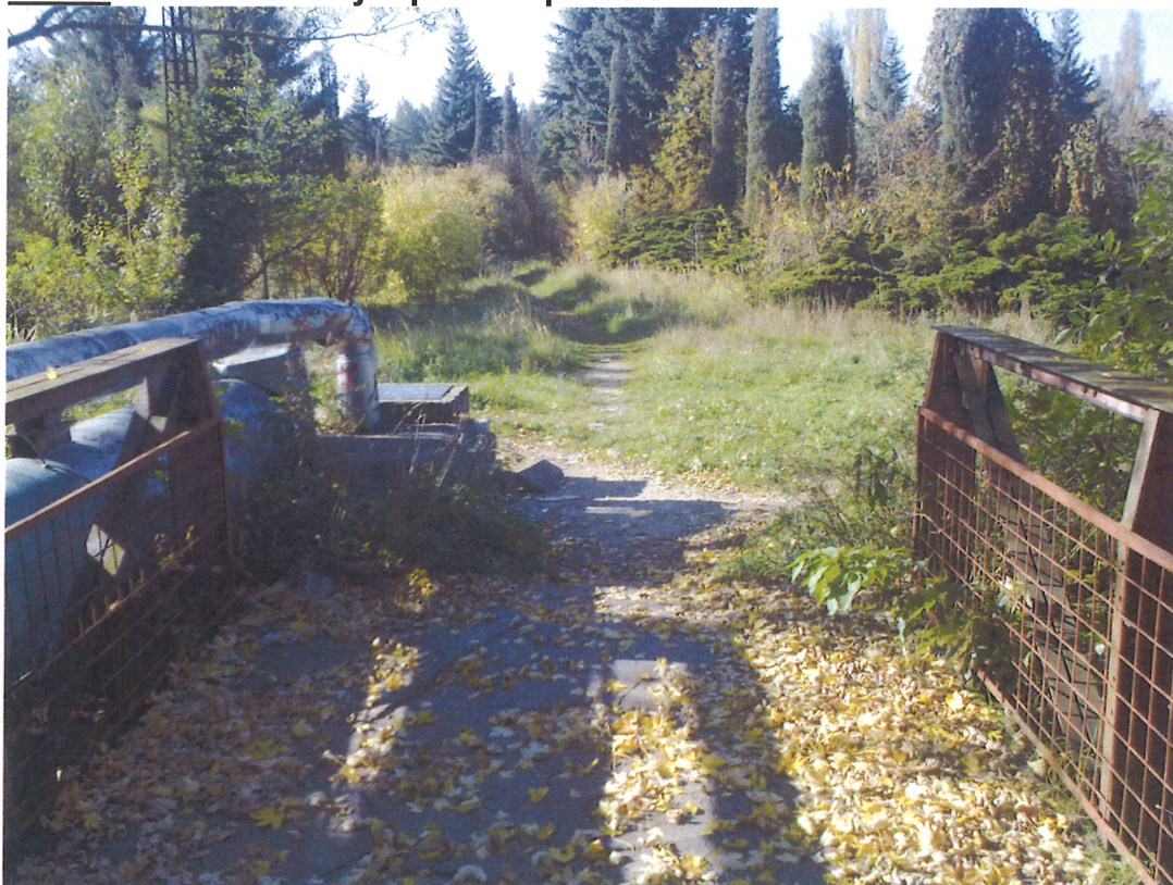
Obr.4: Přejchod teplovodu pod zem na SZ konci lávky
